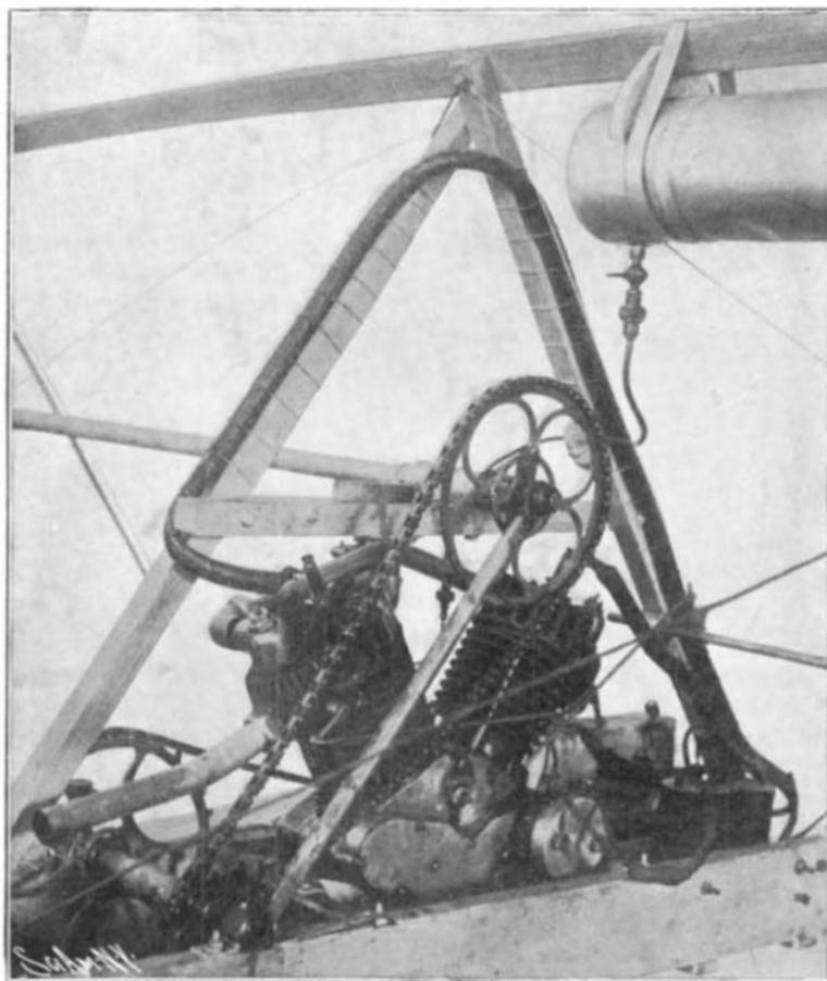
**5-HORSE-POWER CURTIS AIR-COOLED MOTOR AS USED ON THE BALDWIN AIRSHIP.**
