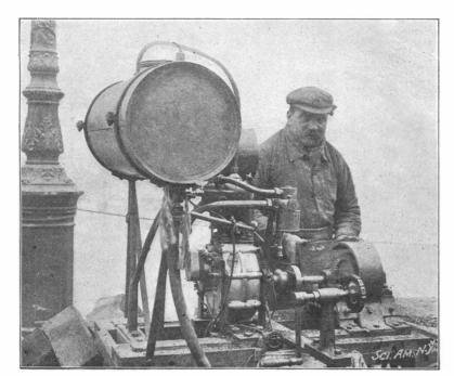
Fig. 3.—MACHINE FOR TRIMMING PAVING BLOCKS.
