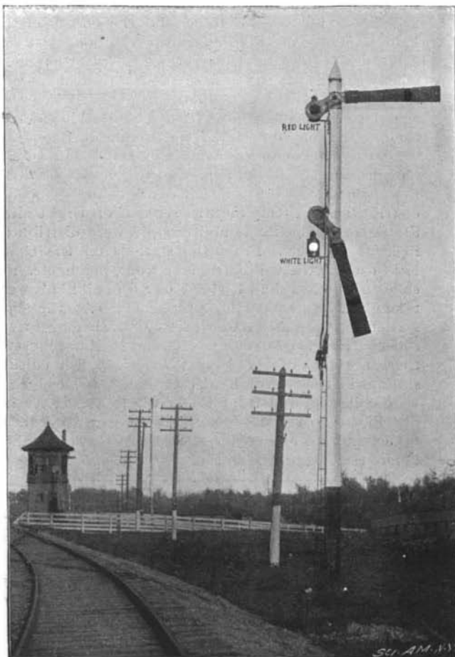
Fig. 1.—SEMAPHORE SIGNAL.
