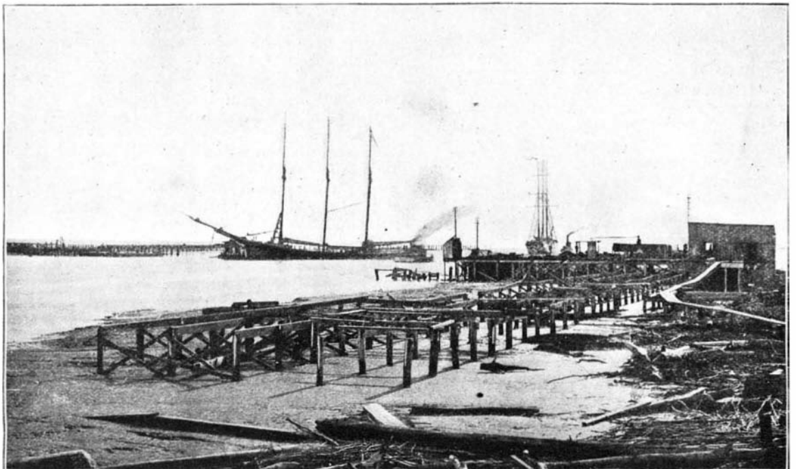
JETTY WORKS, BRAZOS RIVER, TEXAS.
