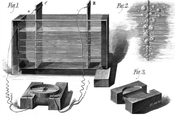
EXPERIMENTAL BATTERY AND GALVANOMETER
